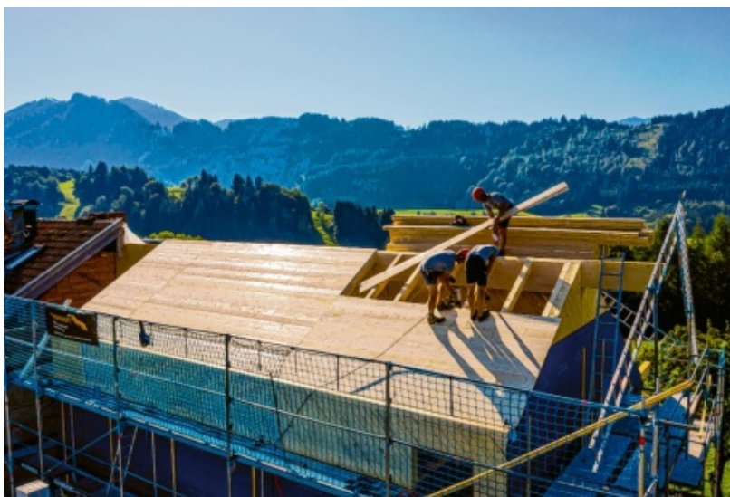
Das Bauen mit Holz wird derzeit beliebter. Abgesehen von den derzeit höheren Holzpreisen hat es viele Vorteile. Foto: Ralf Lienert
